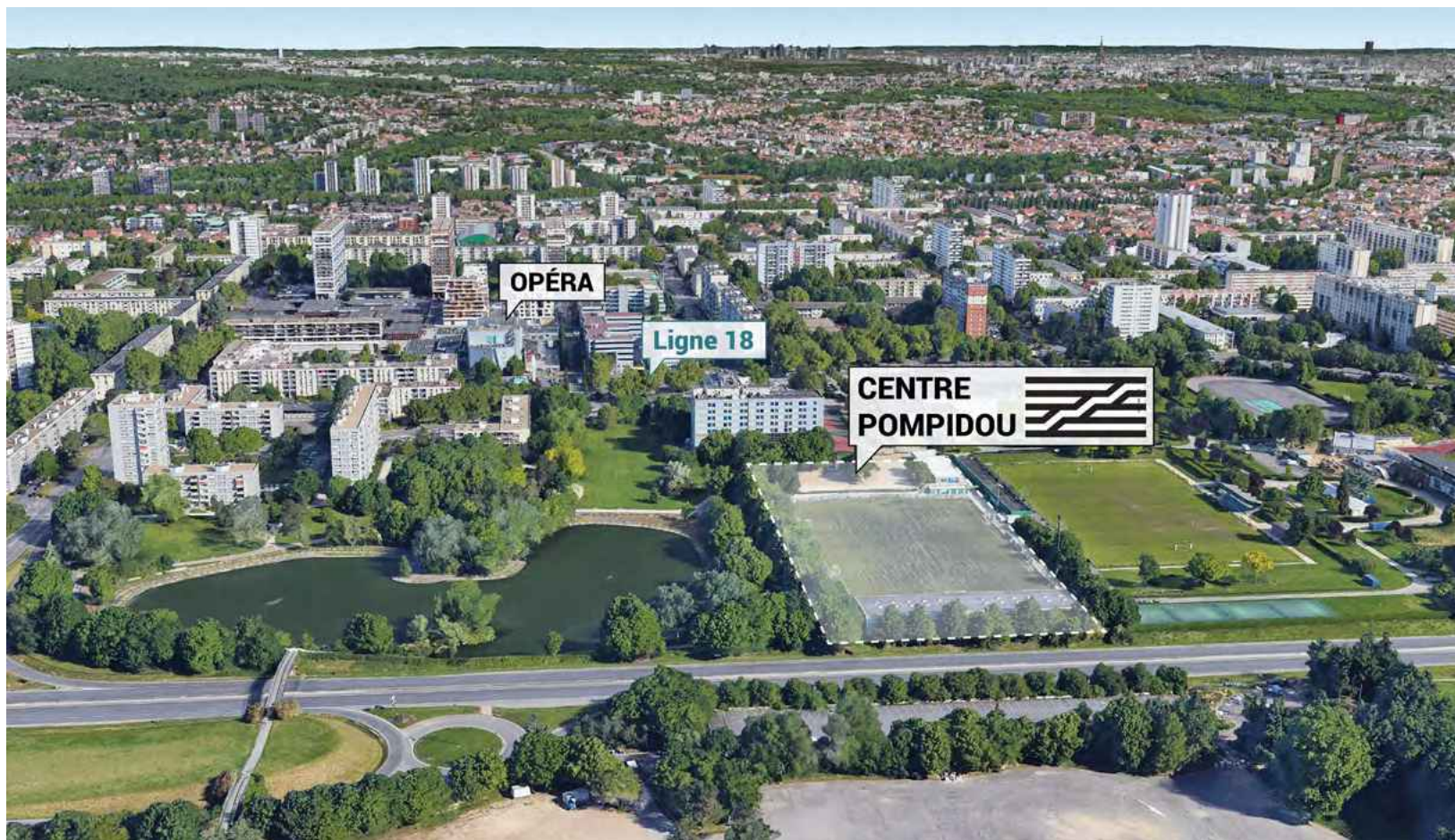
Implantation des futures réserves du Centre Pompidou, 2019
