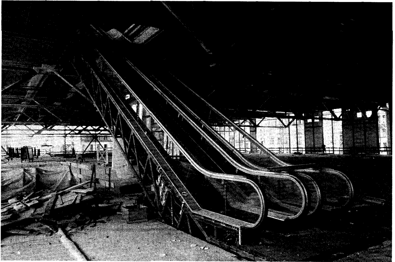
Un des plateaux du Centre en construction
